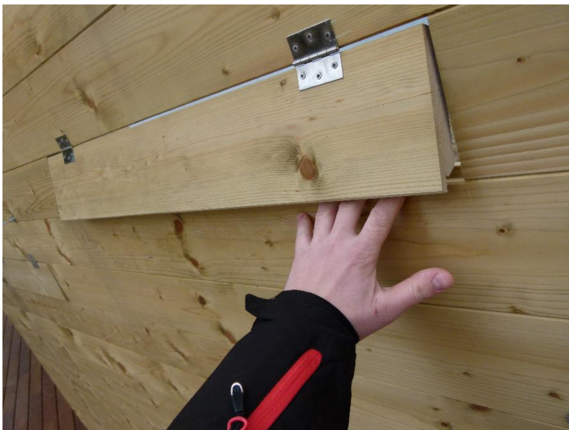
Sl. 21: Opazovalne line na opazovališčih in ostalih objektih v rezervatu - nevarnost poškodb z udarcem ali uščipa.
